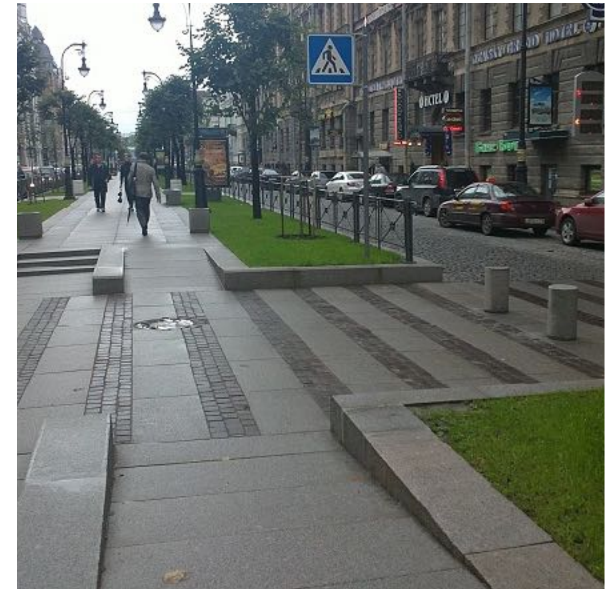
Реконструкция Большой Конюшенной улицы Санкт-Петербург, Россия 2010-2011
